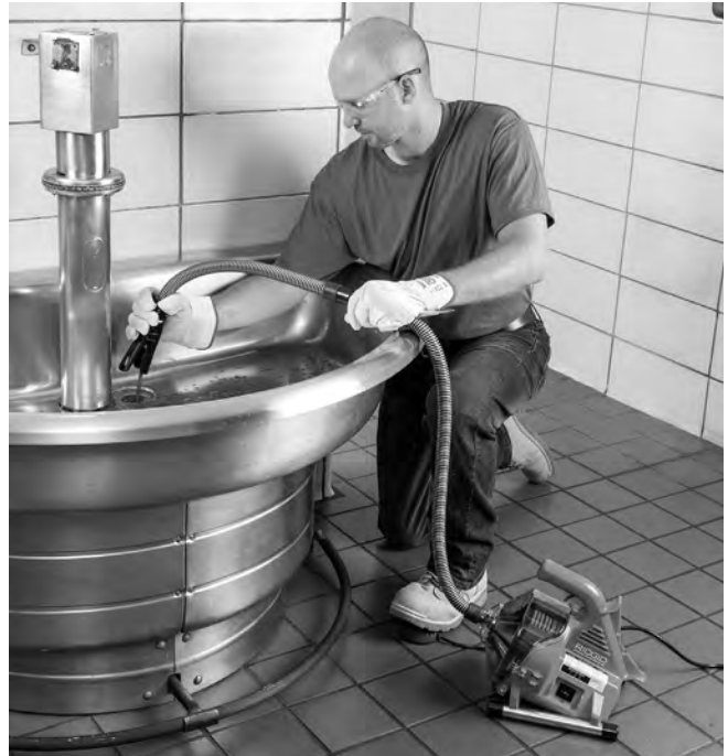
Figur 11 – Trekke ut kabelen
